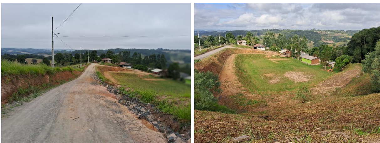
FIGURA 21 – VIA DE ACESSO E ÁREA COMUNITÁRIA DE LAZER DA CRQ VEM
