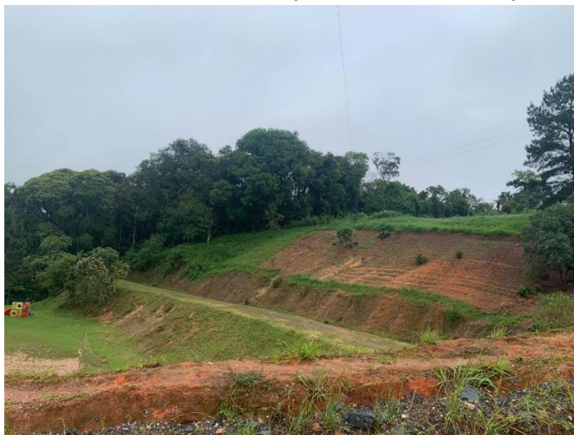
FIGURA 23 – MANEJO INADEQUADO DO SOLO NA CRQ VEM
